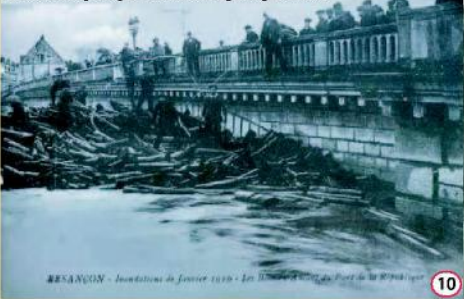
Pont de la République - Les bois sont peu à peu retirés
